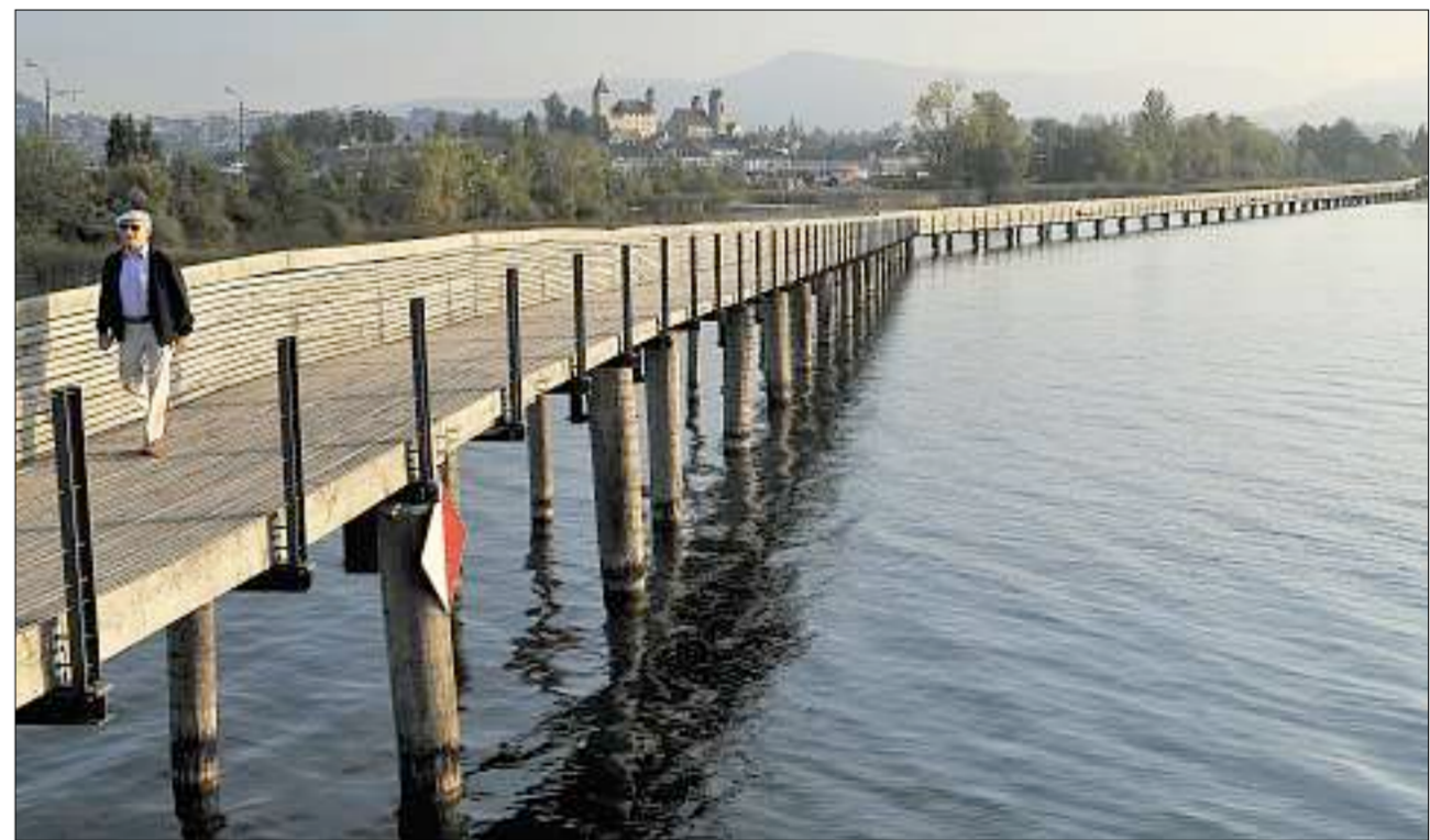
Vorbildlich und beliebt: die 2001 eingeweihte Holzbrücke zwischen Hurden und Rapperswil-Jona. (Manuela Matt)
